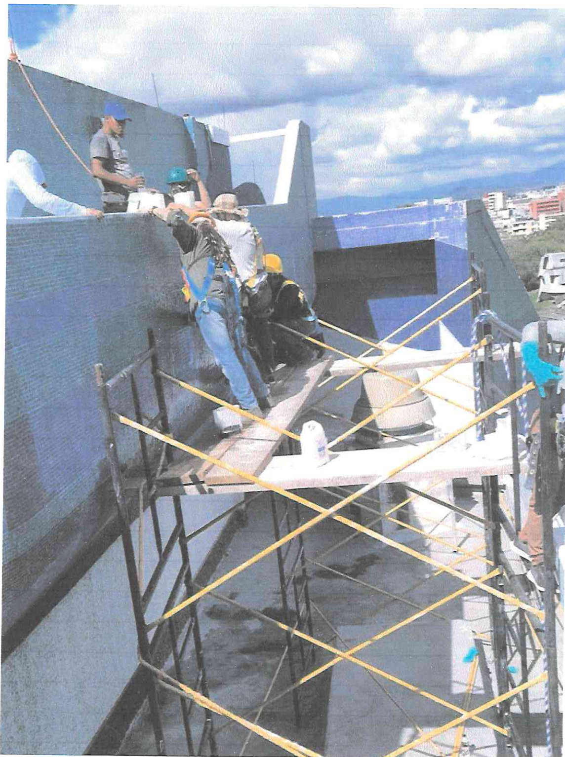
Limpieza y desinfección de teselas en segmento A4 de la fachada Oriente.
